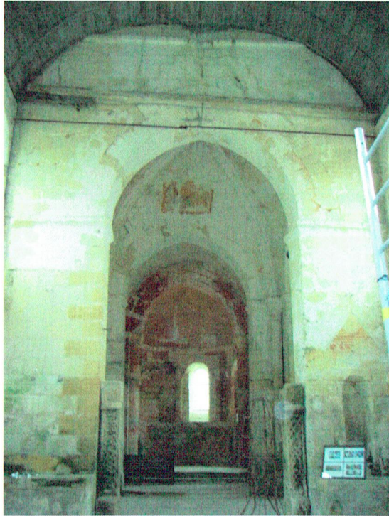
Vue d'ensemble du chœur roman, de l'avant-chœur et de la croisée de transept gothique Noter les proportions héritées de l'antique, de la nef lisible sur l'arc triomphal
